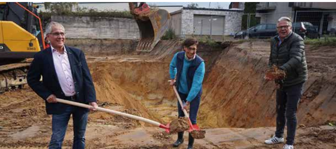
Langenfelds Bürgermeister Frank Schneider, Lebenshilfe-Vorsitzende Nicole Dünchheim und Architekt Peter Stepke (r.) beim offiziellen Spatenstich. Foto: Jürgen Steinbrücker
